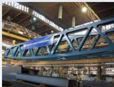
Železniční most Stříbro-Planá, Česká republika, 2008
