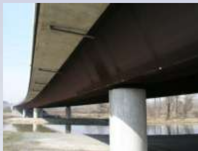
Dálniční most D-47 Rojek, Česká republika, 2006
