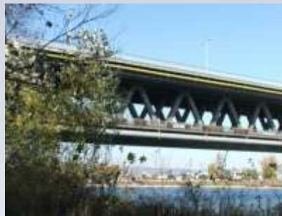
Přístavní most, Bratislava, Slovensko, 1985 silniční s železničním, s lávkou pro pěší a cyklisty a inženýrskými sítěmi
