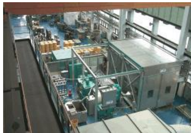
Dekontaminační box pro vysoko tlakovodní otryskávání
