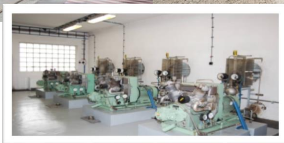
Kompresory v SO 523b:V1 počas demontáže
