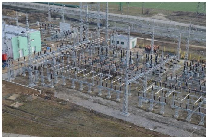
Rekonštrukcia rozvodne 110 kV
