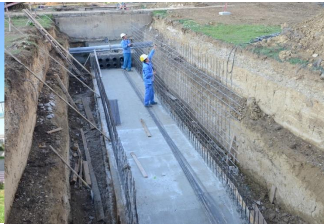
Výstavba nového EK pre MSVP
