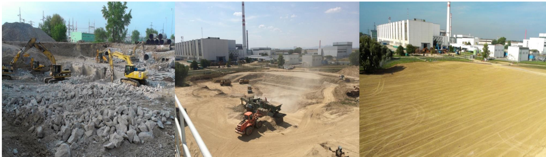
Demolácia Centrálnej čerpacej stanice (stav august 2015)
