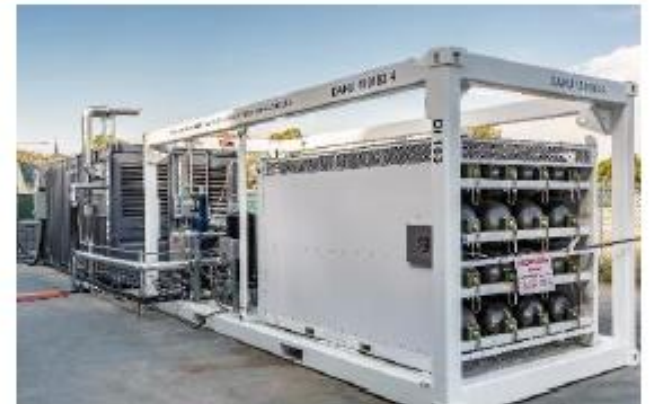
200 kW SOEC unit in Los Angeles, USA
