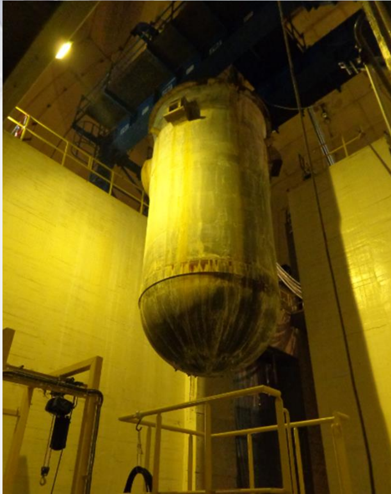
Extrakce jaderného reaktoru Kahl, Německo 2005
